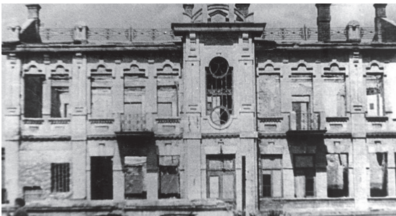
РАЗРУШЕННОЕ ЗДАНИЕ ЦЕНТРАЛЬНОЙ БИБЛИОТЕКИ Г. ГОМЕЛЯ ГОМЕЛЬ ШЭЪФЭРЕ УЗЭК КИТАПХАНЭСЕНЕЦ ЖИМЕРТЕЛГЭН БИНАСЫ
